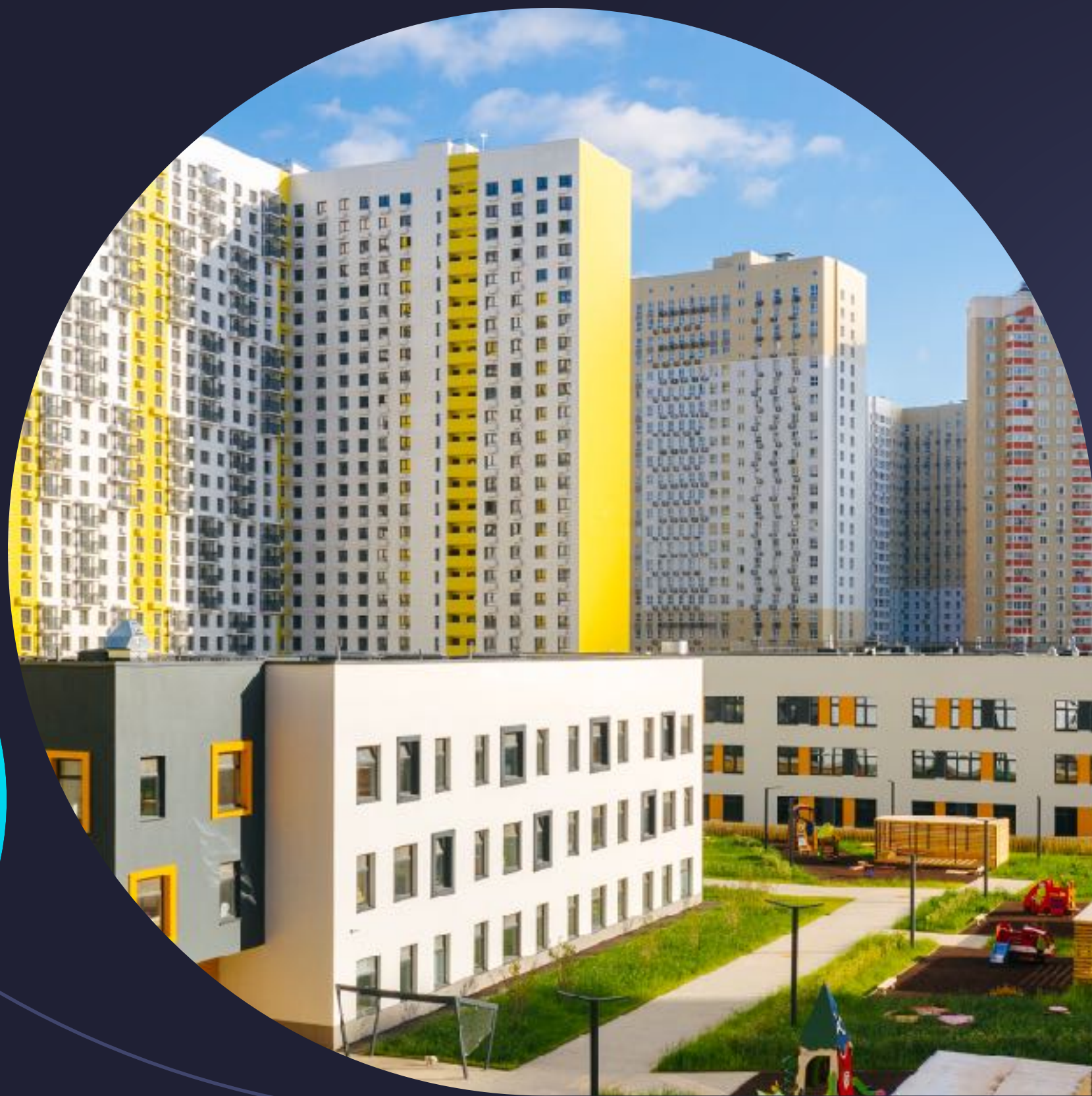
ЖК «Путилково», г. Красногорск
